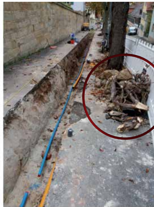
Bild 2: Der Leitungsgraben wurde ca. 1 m von den Kastanienstämmen verlegt, darin wurden alle vorhandenen Wurzeln bis 1 m Tiefe abgelagert – rechts Wurzelstücke von Kastanien. In der nördlichen Baugrubenwand steht teilweise massiver Sandsteinfels des Sandsteinkeupers an.
