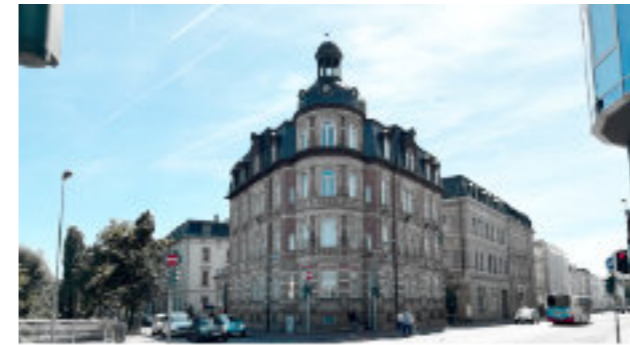
Oben: Der früheste von ihm erhaltene Entwurf Mittelstraße 48; Unten: Heinrichsdamm 7. Markanter Auftakt in das von ihm wesentlich mitgeprägte Viertel östlich der Willy-Lessing-Straße.
