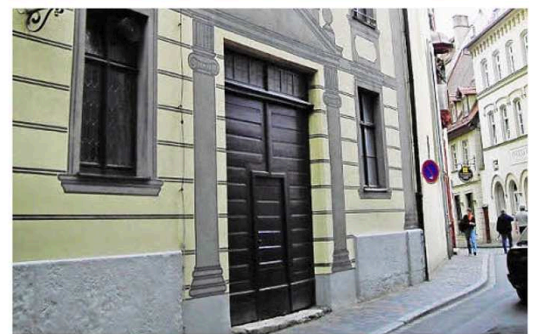
Der vormalige Zustand mit der noch immer vorhanden und funktionstüchtigen historischen Tür
