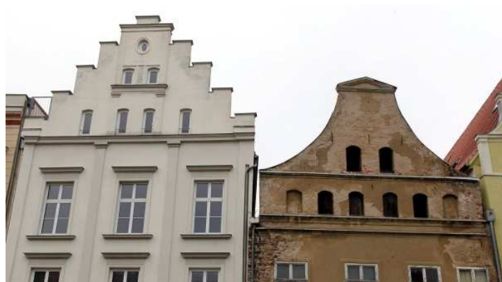
Sanieren, ohne das Stadtbild zu zerstören: Zwei Häuser in der denkmalgeschützten Altstadt von Stralsund © DAPD
